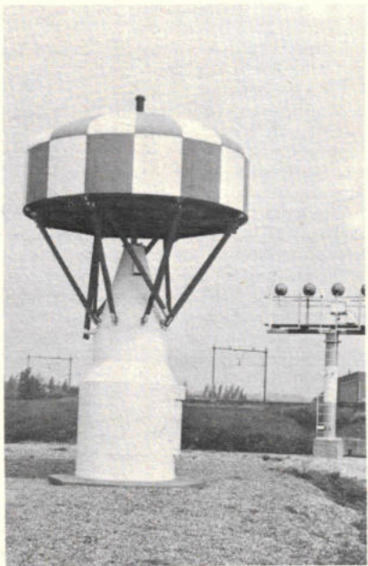
Afb. 66. Doppler-peiler tussen de landingslichten op de luchthaven Zestienhoven bij Rotterdam (geschikt voor vier frequenties).
